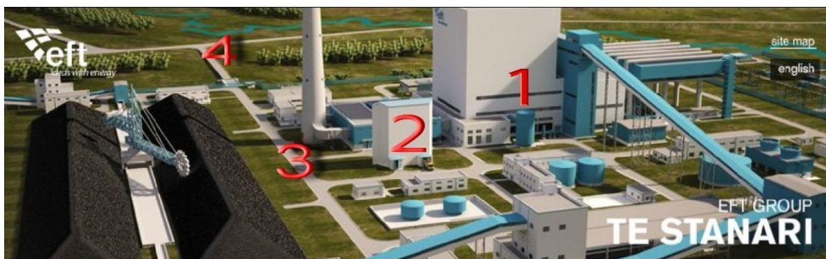
Slika 3. Položaj bunkera pepela sa dna kotla (bottom ash-1) i letećeg pepela (fly ash-2), u krugu TE Stanari
