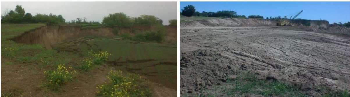
Slika 1. Vršna etaža na severnoj kosini PK Ćirikovac (pre i nakon sanacije) [1]
