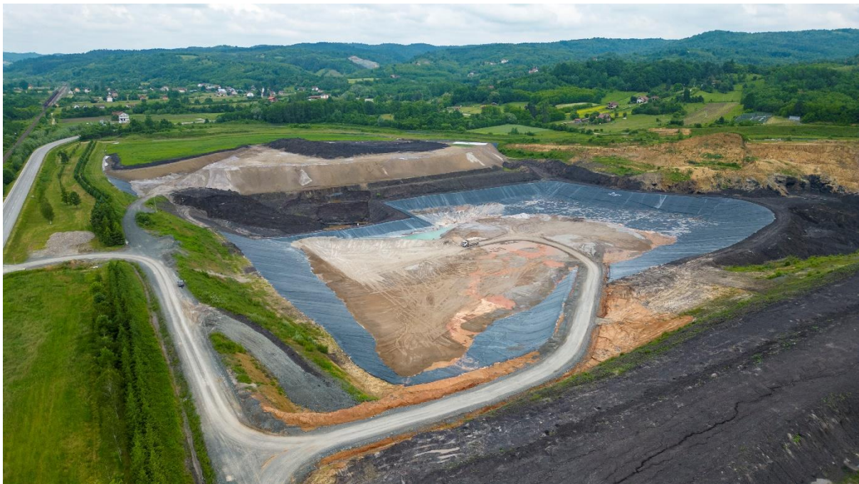
Slika 6. Depovanovanje čvrstih ostataka sagorijevanja u kaseti
