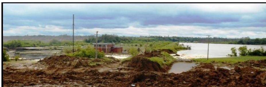
Slika 8. Brana, retenzija i crpna stanica Kladnica nakon poplava 2014. godine
